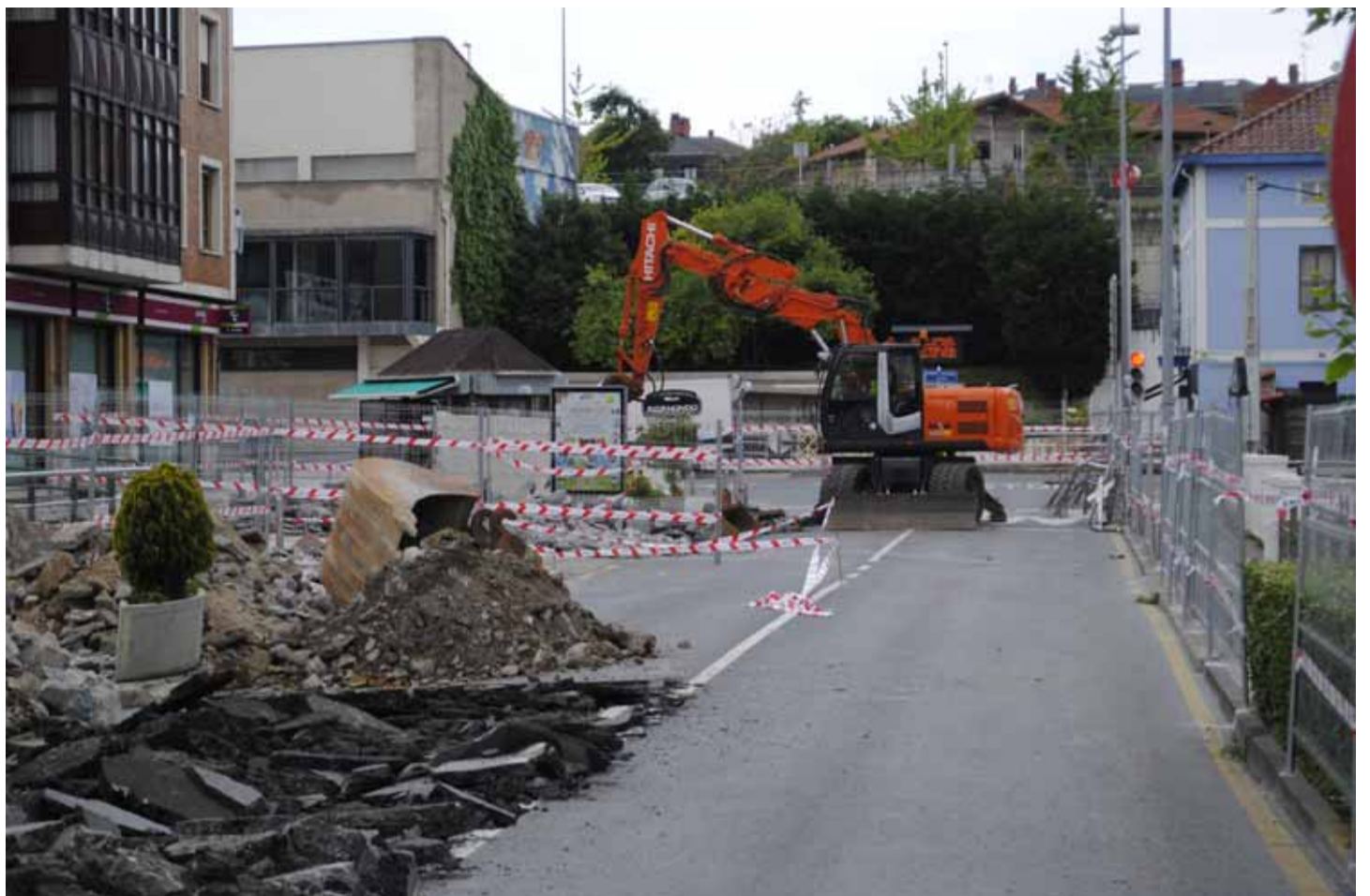
Las obras de la calle Sabino Arana marchan a buen ritmo.
