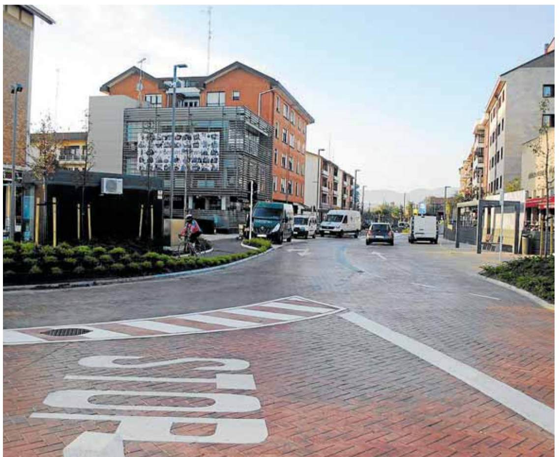
Las obras de la calle Sabino Arana han incrementado los espacios peatonales.
